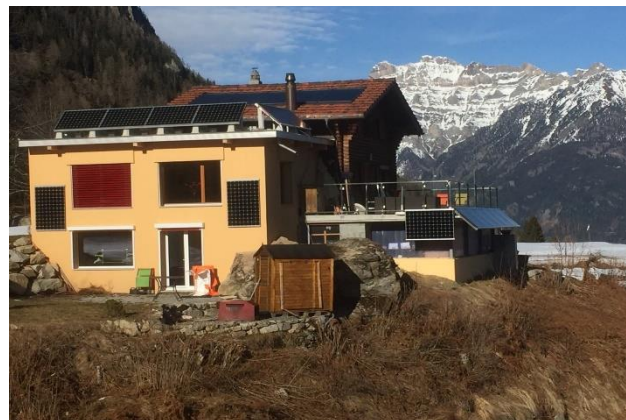
Production d'énergie solaire sans considération pour la qualité du bâti © Oliver Martin.
