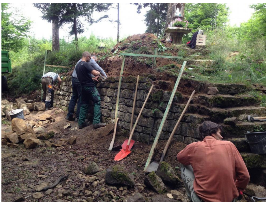
Le premier INTERREG chantier formation de restauration en pierre sèche, Heisgeskraiz, Larochette (L), Natur- & Geopark Mëlldall (labelisé UNESCO Géoparc mondial en 2022).
